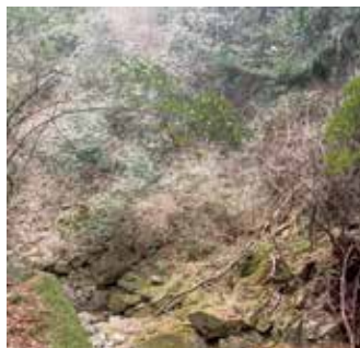
トンネル工事により水の流量がほぼなくなった状態の二之瀬の御井当谷川
