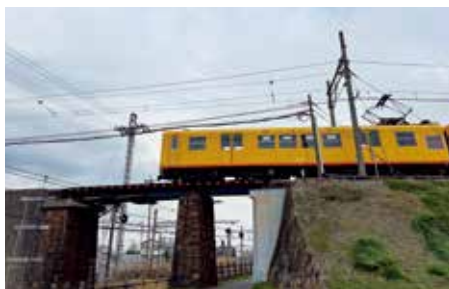
令和8年度に全47橋梁の耐震調査を実施。 西桑名駅～馬道駅間の橋梁
