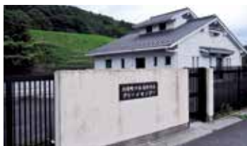
農業集落排水処理施設 (北勢町十社南部地区クリーンセンター)
