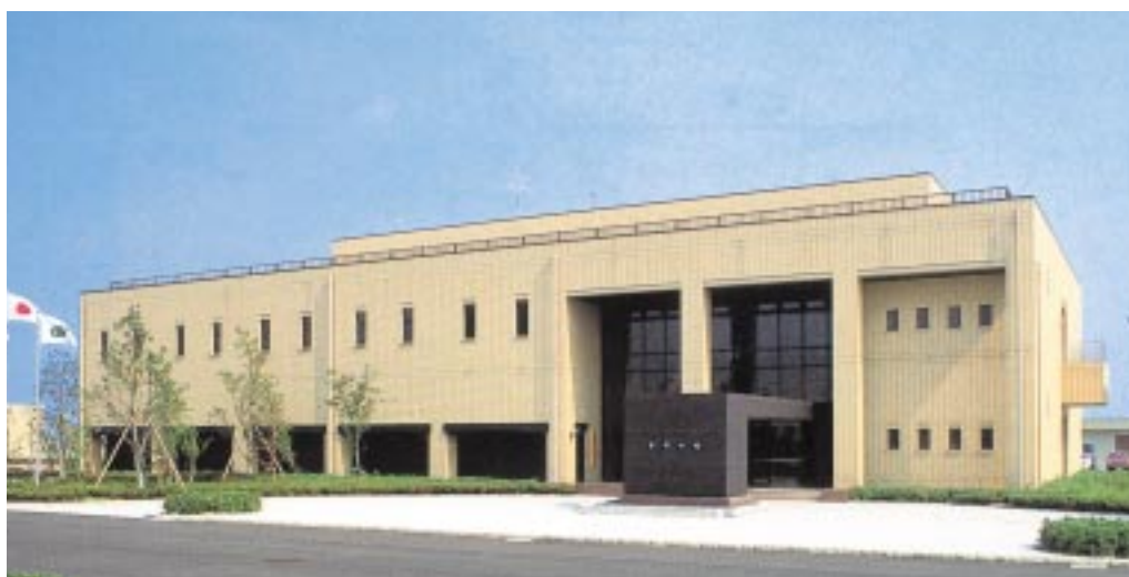
北部浄化センター
