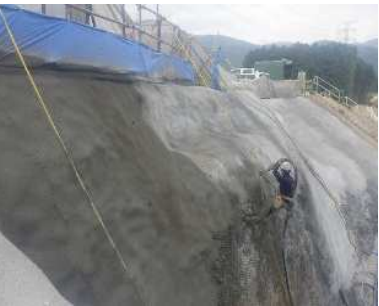
モルタル吹付
