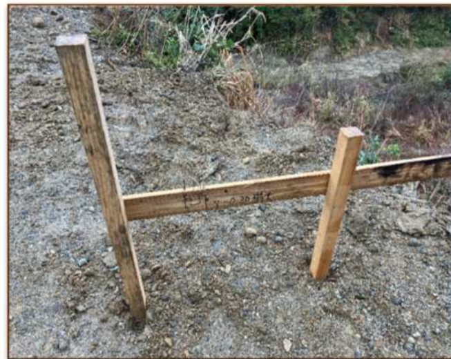
・仕上がりの高さを確認するための目印
