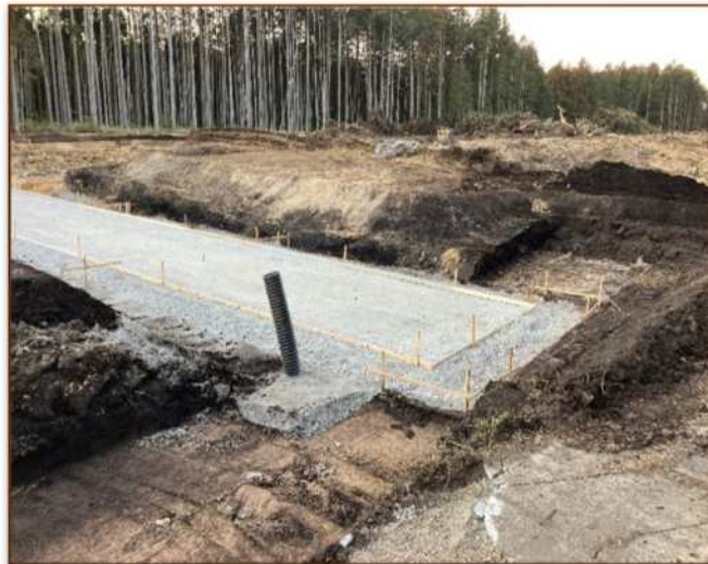
・構造物等の位置を可視化するための目印
