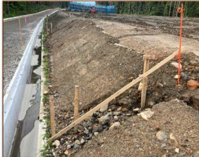
・斜面（法面）を削る（盛る）際の目印
