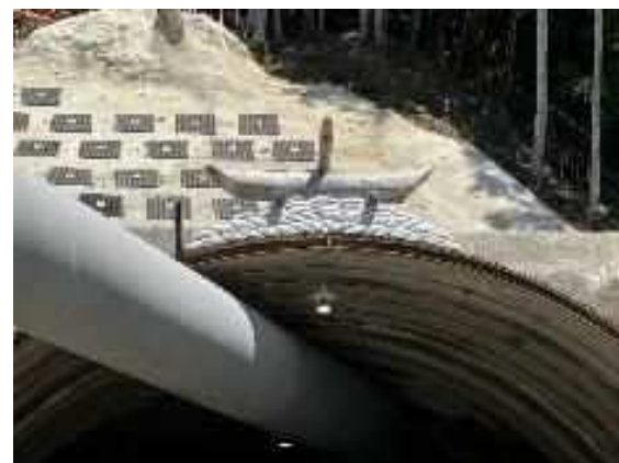
↑ 以前紹介しましたが、トンネル坑口には化粧木と呼ばれる木を置いて工事の安全を祈願します。
