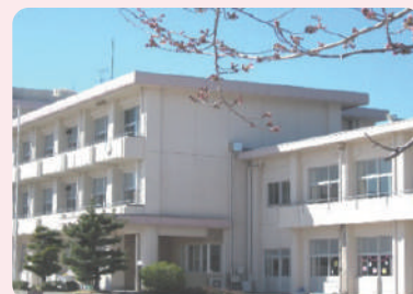
山郷小学校のバリアフリー化改修
