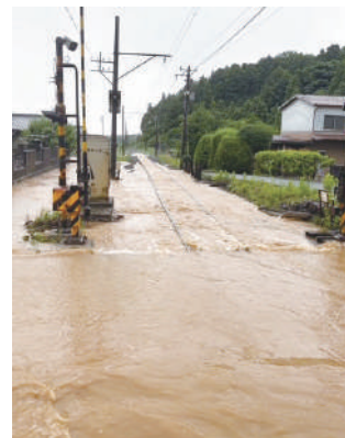
豪雨により冠水した西野尻駅付近の線路
