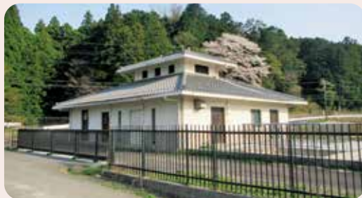
東貝野地区クリーンセンター
