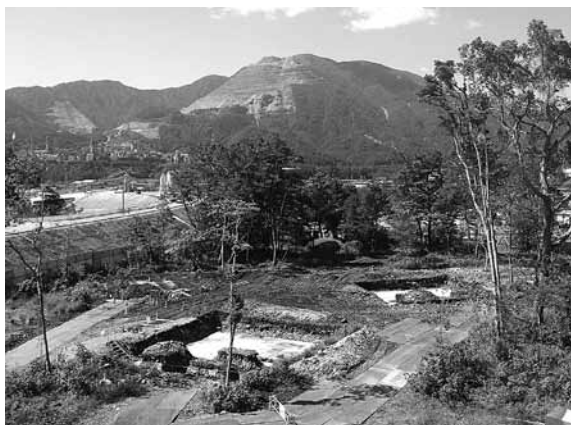
「にぎわいの森」建設中
