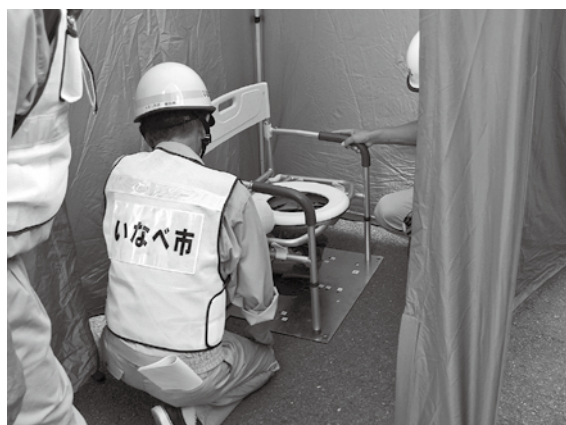
マンホールトイレ
