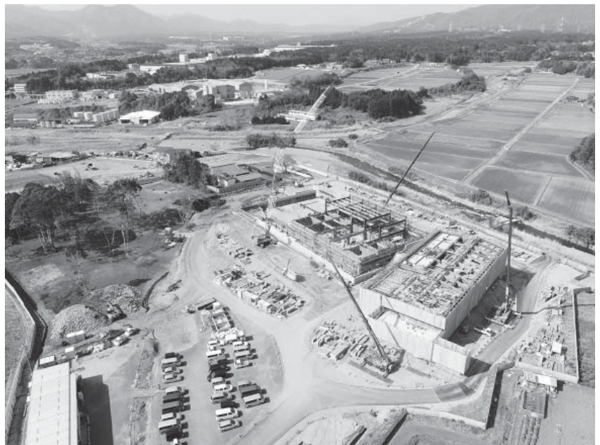
建設が進む新庁舎、保健センター等
