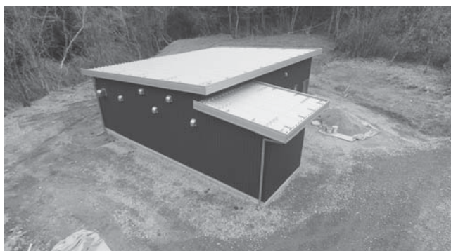
建設中の「ジビエ工房」
