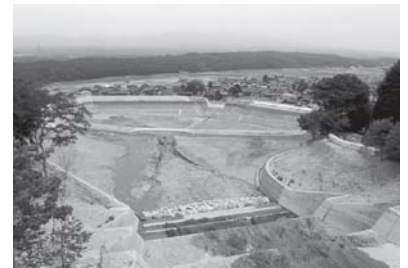
小滝川（藤原町坂本）遊砂地かさ上げ工
