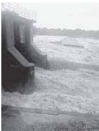
員弁川第二頭首工
