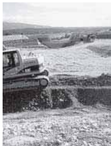
小滝川砂防堰堤
