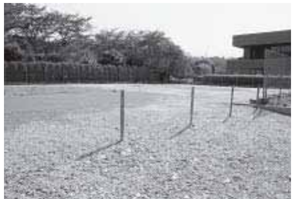
大安公民館前駐車場整備予定
