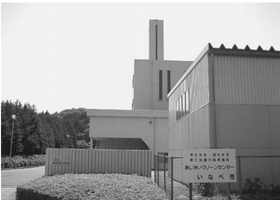
大規模改修工事を行う あじさいクリーンセンター
