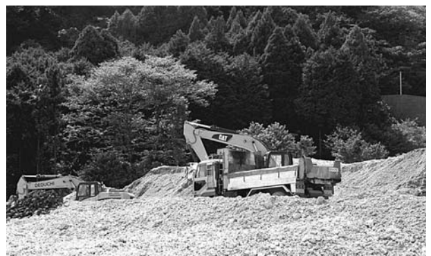
急ピッチで溜まった土砂を取り除く作業（小滝川）
