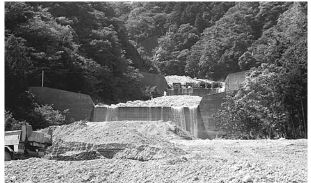
手前から土砂で埋め尽くされた遊砂地、1号、2号ダム（小滝川）
