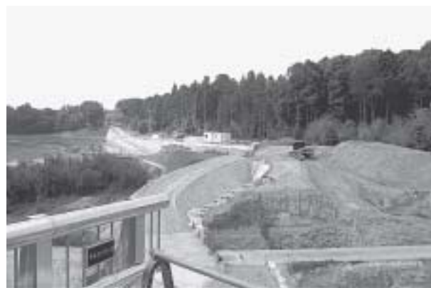
笠田新田坂東新田線の複雑な路盤で難工事の完成も近い
