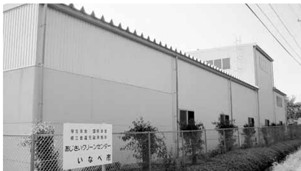
大規模改修を行うあじさいクリーンセンター
