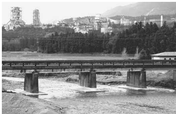
橋台工事を行っている野尻橋
