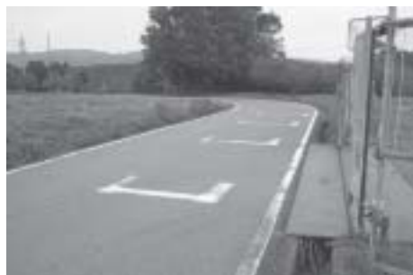
市道山第74号線（山郷保育所建設現場前）
