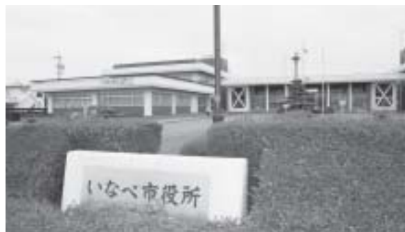
現在の本庁舎（旧員弁町役場）
