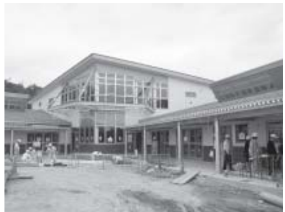
9月の開園をめざし工事が行われています。(6月撮影)
