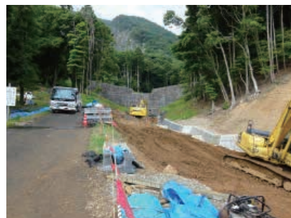
少部原谷川溪流保全工事
