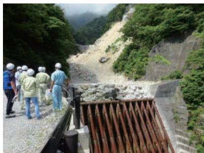
小滝川砂防施設 4号堰堤
