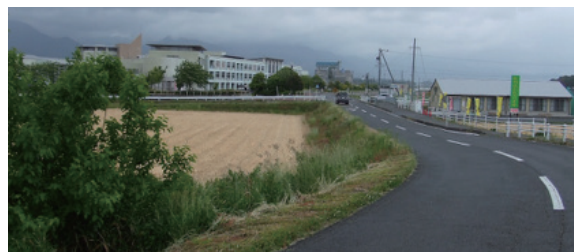
自歩道整備のため測量設計を行う西方上笠田線
