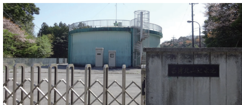
石博北山配水池
