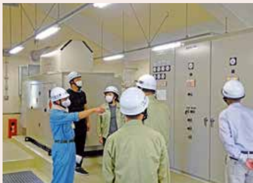
麻生田水源を現地視察
