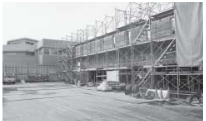
体育館とプールを建設中の員弁西小学校
