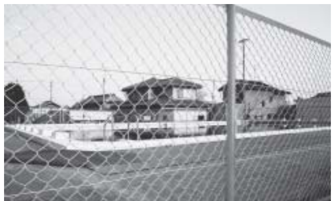
老朽化した笠間小学校のプール
