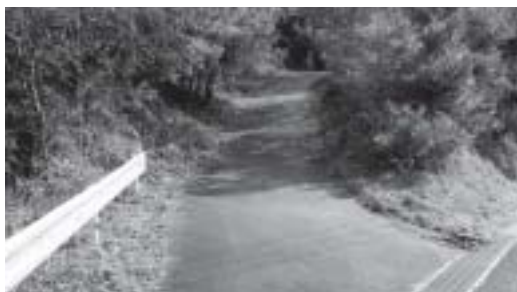
市道長尾篠立支1号線（終点から撮影）
