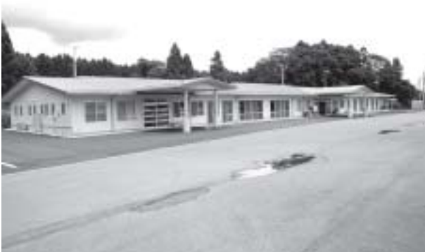
障害者活動支援センター（大安町中央公民館西）
