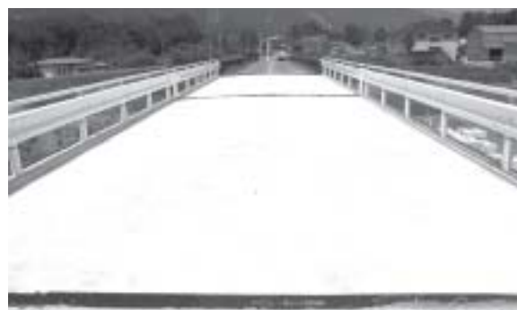
舗装前の野尻橋
