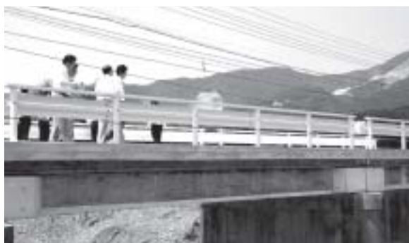
工事途中の野尻橋（下野尻地区）
