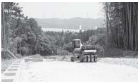
市道笠田新田坂東新田線道路改良工事（坂東新田地区）
