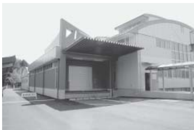
増改築された大安給食センター
