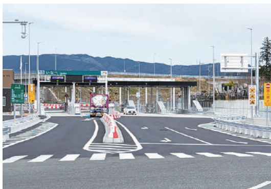
令和7年3月29日に開通した東海環状自動車道いなべインター
