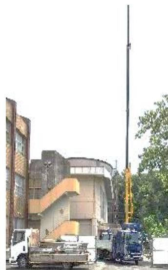
クレーンの高さは、30mまで伸びます。
