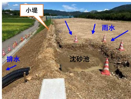
盛土表面の水は、沈砂池に向かって勾配を付け、一度沈砂（泥を沈殿）させてから、排水します。沈砂池を経由することで、土砂の流出を防止します。また、法肩に小堤を作ることがとても重要です。小堤を作り、排水勾配を確保することで、法面が崩れることを防ぎます。もし、排水対策を行わなかったら・・・
