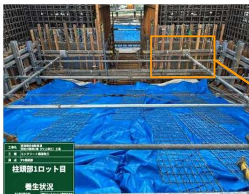
柱頭部は橋脚からの鉄筋と橋梁本体の鉄筋が組まれ密な状態となります。当現場ではアクリルの透明型枠を使用し、コンクリートの充填状況を把握することで、コンクリートの品質を高めています。
