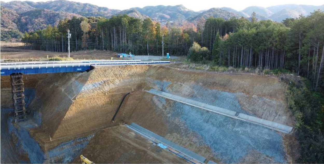
奄芸層群の特徴である砂礫とシルトの互層構造がよくわかる掘削箇所（北工区）
