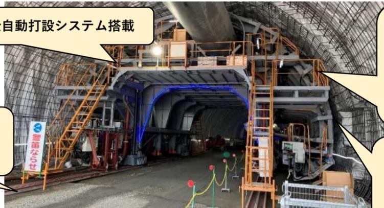
白い防水シートとセントル(型枠)の間に、覆工コンクリートを打込みます。厚さは30~40cmと意外と薄いコンクリートです。
