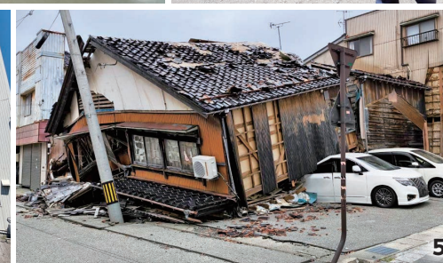
1. 今にも崩れそうな調査対象家屋の中に入るため、ヘルメット着用 2. 調査後は認定作業に入る 3.4. 住宅の基礎部分に損傷を受けていないかなどを調べる 5.1階部分がつぶれた家屋が多く見られた
