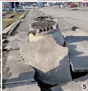
1.4. 輪島市内の建物倒壊 2. 崩れた山肌 3.1 階部分がつぶれた住居 5. 液状化により突き出たマンホール 6. 棚から崩れ落ちた食器
