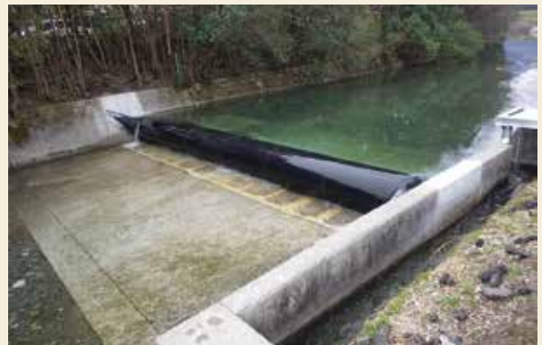
片樋ゴム堰改修工事
