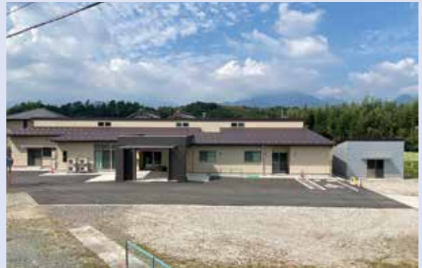
令和4年2月に完成した、障がい者グループホーム「バンブーハウス」
