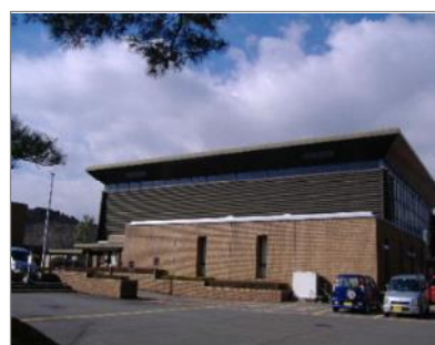
<大安スポーツ公園体育館>
