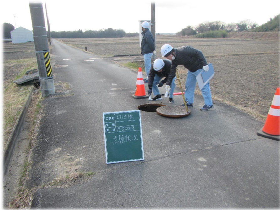
マンホールの内部を点検する職員
