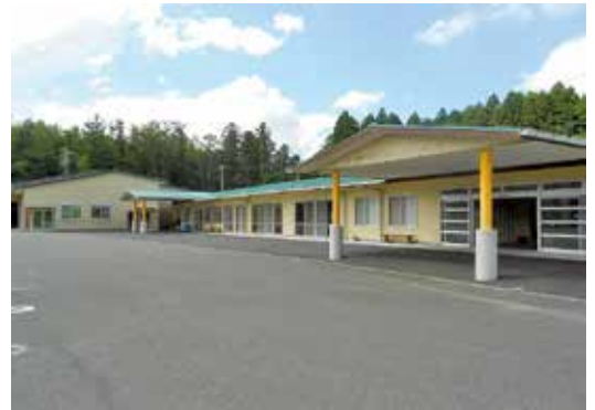
いなべ市障害者活動支援センター
