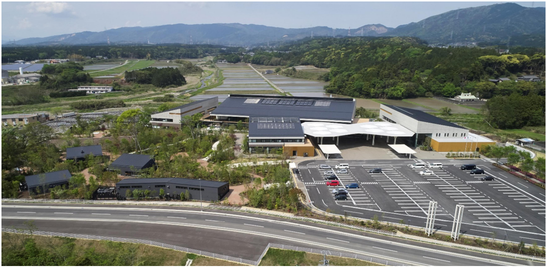
(南側外観全景)
