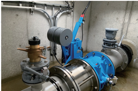
阿下喜配水池緊急遮断弁
