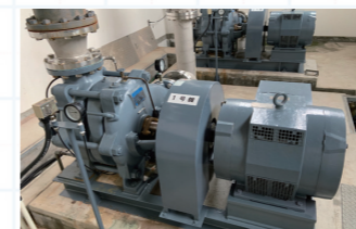
◀東貝野送水ポンプ
