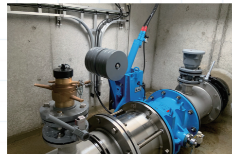
阿下喜配水池緊急遮断弁
