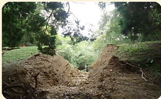
平成25年9月、台風18号による大雨により決壊したため池
