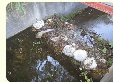
土のうによる洪水吐のかさ上げ
