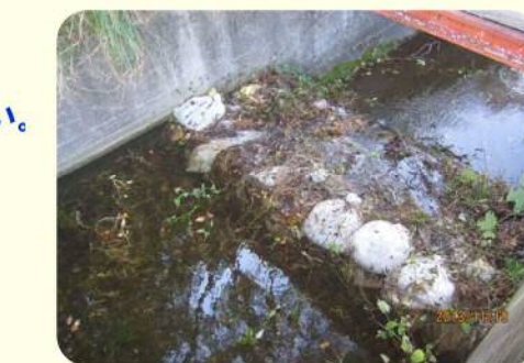
土のうによる洪水吐のかさ上げ
