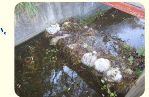
土のうによる洪水吐のかさ上げ
