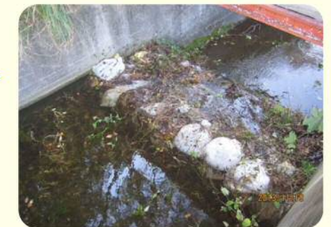
土のうによる洪水吐のかさ上げ
