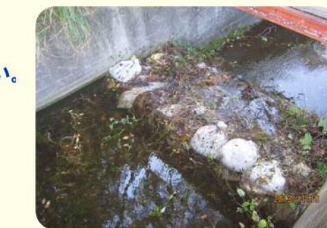
土のうによる洪水吐のかさ上げ
