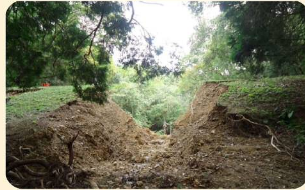
大雨により決壊したため池
