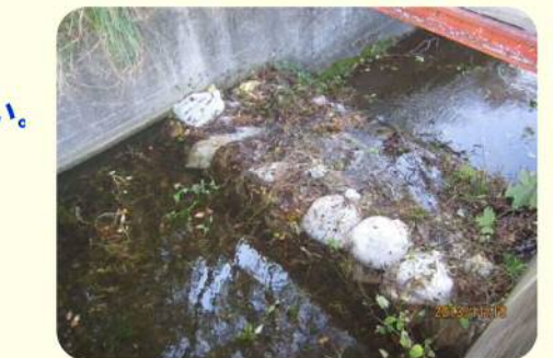
土のうによる洪水吐のかさ上げ
