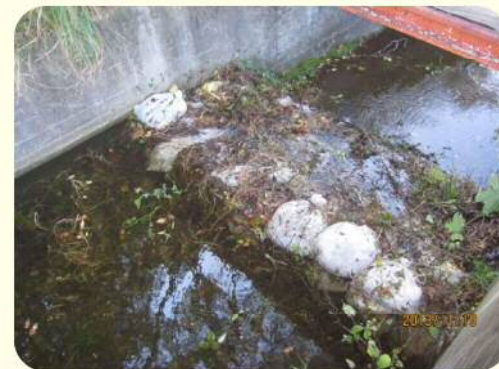
土のうによる洪水吐のかさ上げ
