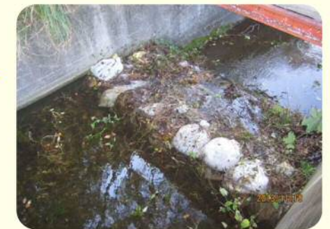
土のうによる洪水吐のかさ上げ
