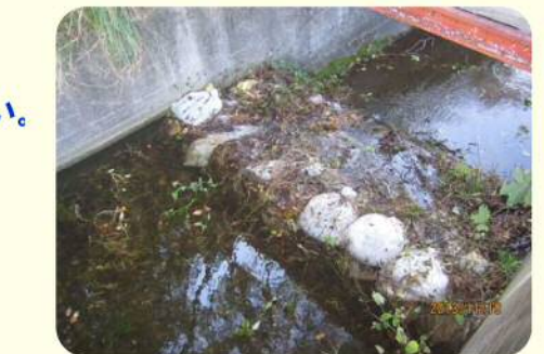
土のうによる洪水吐のかさ上げ
