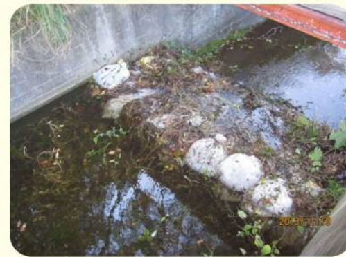
土のうによる洪水吐のかさ上げ
