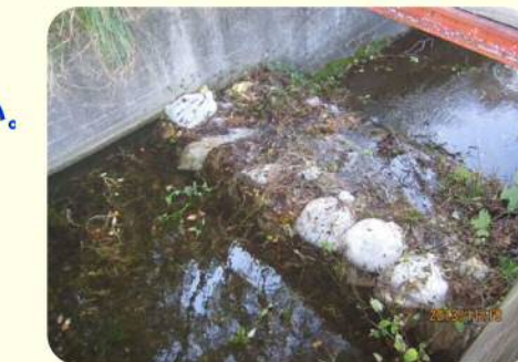
土のうによる洪水吐のかさ上げ
