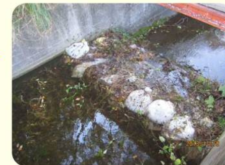
土のうによる洪水吐のかさ上げ
